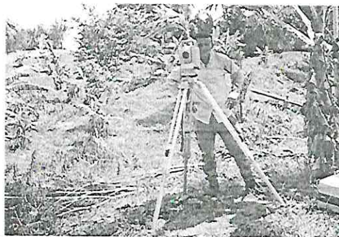
Trabajados de Replanteo.
